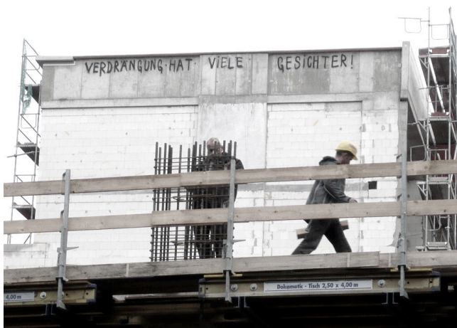
„Verdrängung hat viele Gesichter!“ Oktober 09 auf der Baustelle Karl-Kunger Ecke Lohmühle
